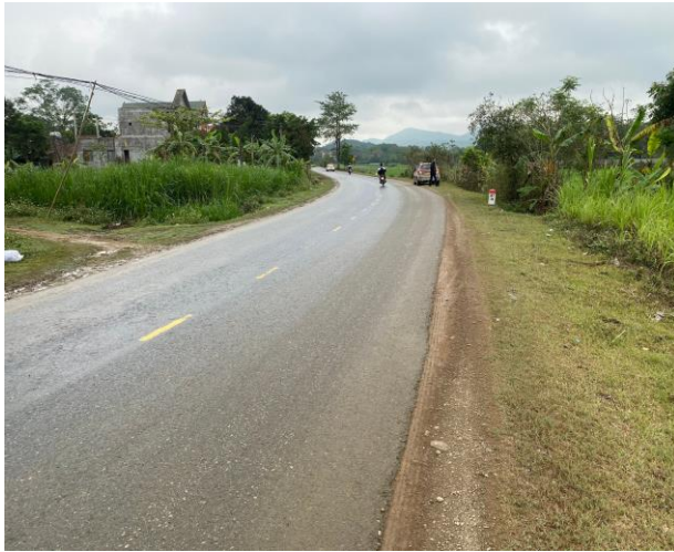
Tuyến đường quốc lộ 217 phía Tây dự án
